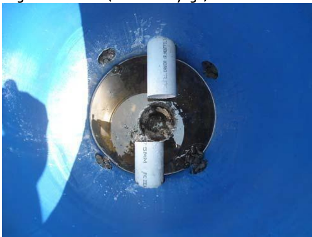
Regard de collecte (avant nettoyage)
