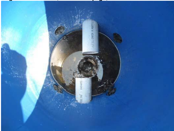
Regard de collecte (avant nettoyage)
