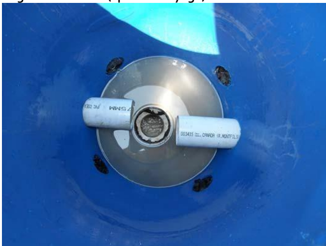
Regard de collecte (après nettoyage)
